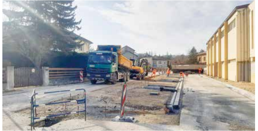
Mise en place des bordures et décapage pour les stationnements - avec sens de circulation - devant le gymnase
